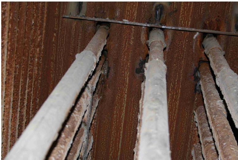
Figur 4. Tuber på ovansidan av sekundäröverhettaren, tuberna manuellt rensade och nyligen monterade tubskydd.
