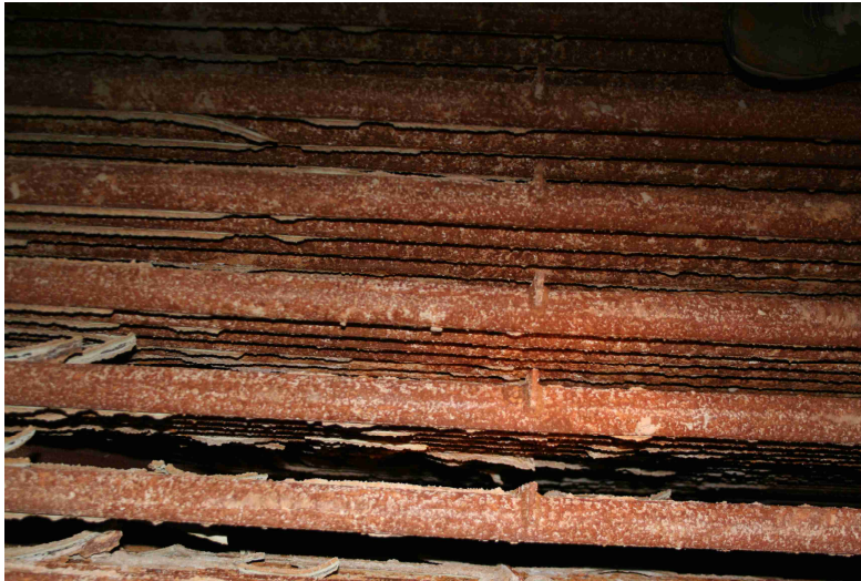
Figur 6. Tuber på ovansidan av kokytan, tuberna manuellt rensade.
