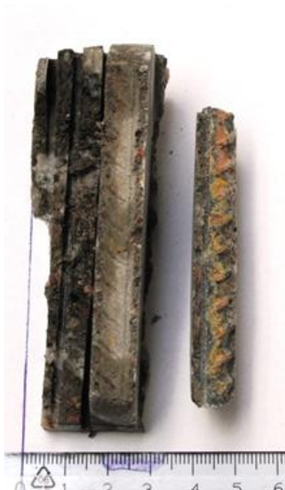
Figur 19. Närbild av betongskikt och armeringsjärn från borrhärna tagen från väggen (Örebro)
