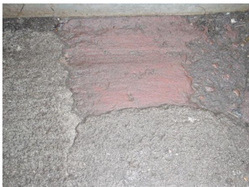
Figur 6. Korrosionsskador på Borlänges anläggning efter att reparation av betongytan har utförts
