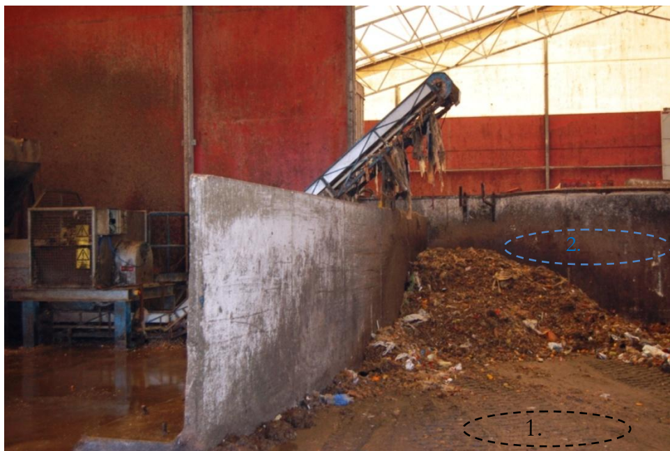
Figur 20. Översiktsbild över konstruktionsdelar (ellips 1 och 2), där förekomsten av armeringskorrosion undersöktes (NSR)
