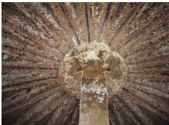
Figur 2. Korrosionsskador på NSR mottagningstank
