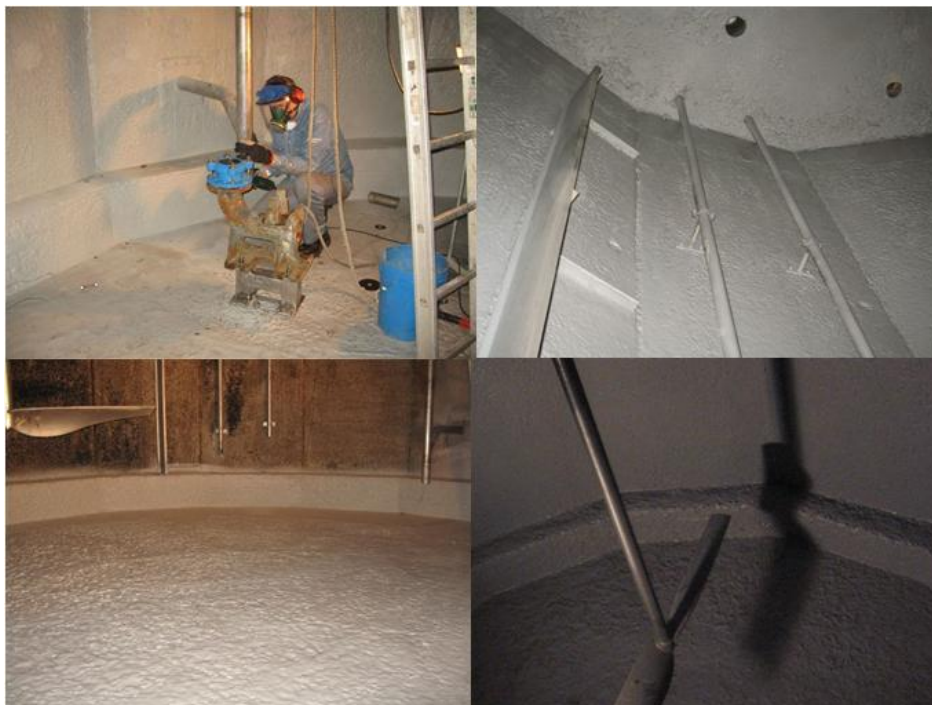
Figur 7. Bilder från beläggningsarbete på Falköpings biogasanläggning med produkten Matakryl
