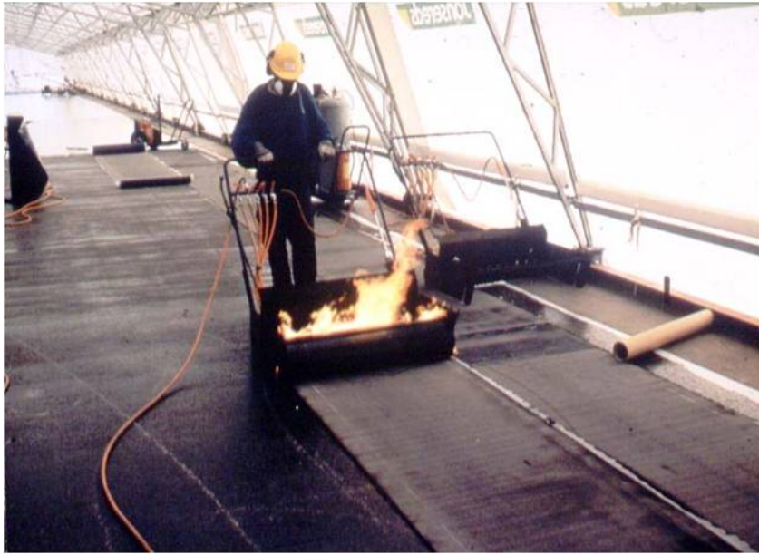
Figur 8. Svetsapplicering av bitumenmatta Figure 8. Torch-welding of bitumen sheet
