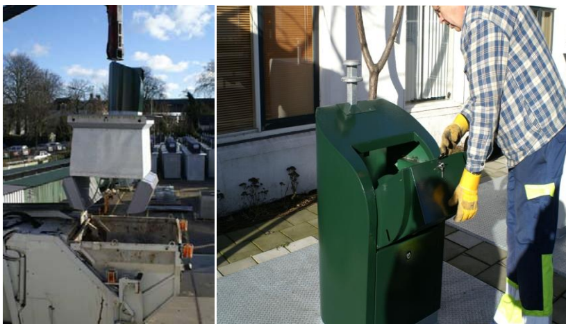
Figur 6. Till vänster: Fully underground underjordsbehållare med dubbelbotten typ Evolution Bio UWS Till höger: Inkast med inspektionsmöjligheter (bildkälla PWS AB)
