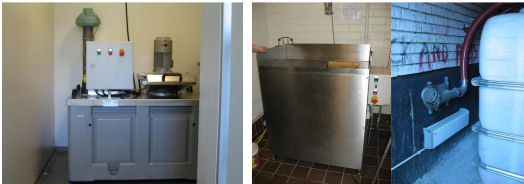
Figur 13. Till vänster: Kvarn och tank sammankopplade till en enhet. Till höger: Enklare lösning med kvarn i köket och tank i anslutande soprum (bildkälla Stockholm stad)
