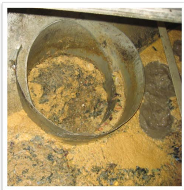
Figur 18. I bioseparatören bräddas substratet för att pumpas till bufferttanken. (Foto: Johan Yngvesson)
