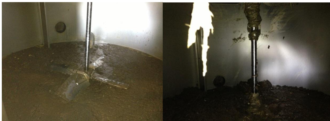
Figur 2 Bilder från anläggningen innan respektive efter testet Figure 2 Images from the facility before and after the test was performed
