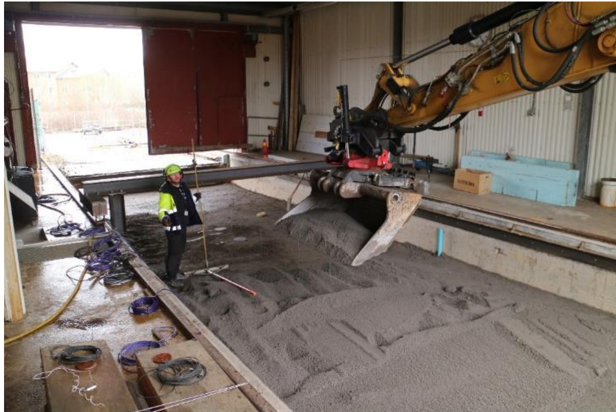
Utläggning obundet bärlager
